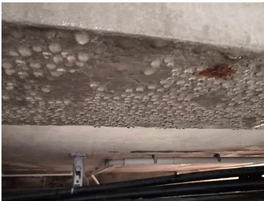
Obrázek 4: Srážení vlhkosti na betonovém trámu ve stávajícím kolektoru
